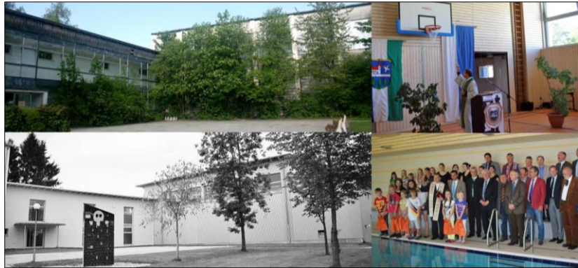
Bilder links: Turnhalle, Hallenbad und Zwischentrakt vor und nach dem Umbau. Bilder rechts: Für insgesamt 2,45 Millionen Euro wurden ab September 2009 die Turnhalle, das Hallenbad und der Zwischentrakt saniert. Bereits am 24.09.2010 weihte Pfarrer Heinrich Anzeneder die neue Turnhalle, ab Oktober 2011 war das Hallenbad wieder in Betrieb und wurde im Juni 2012 feierlich eingeweiht. Fotos: Pree/PNP
